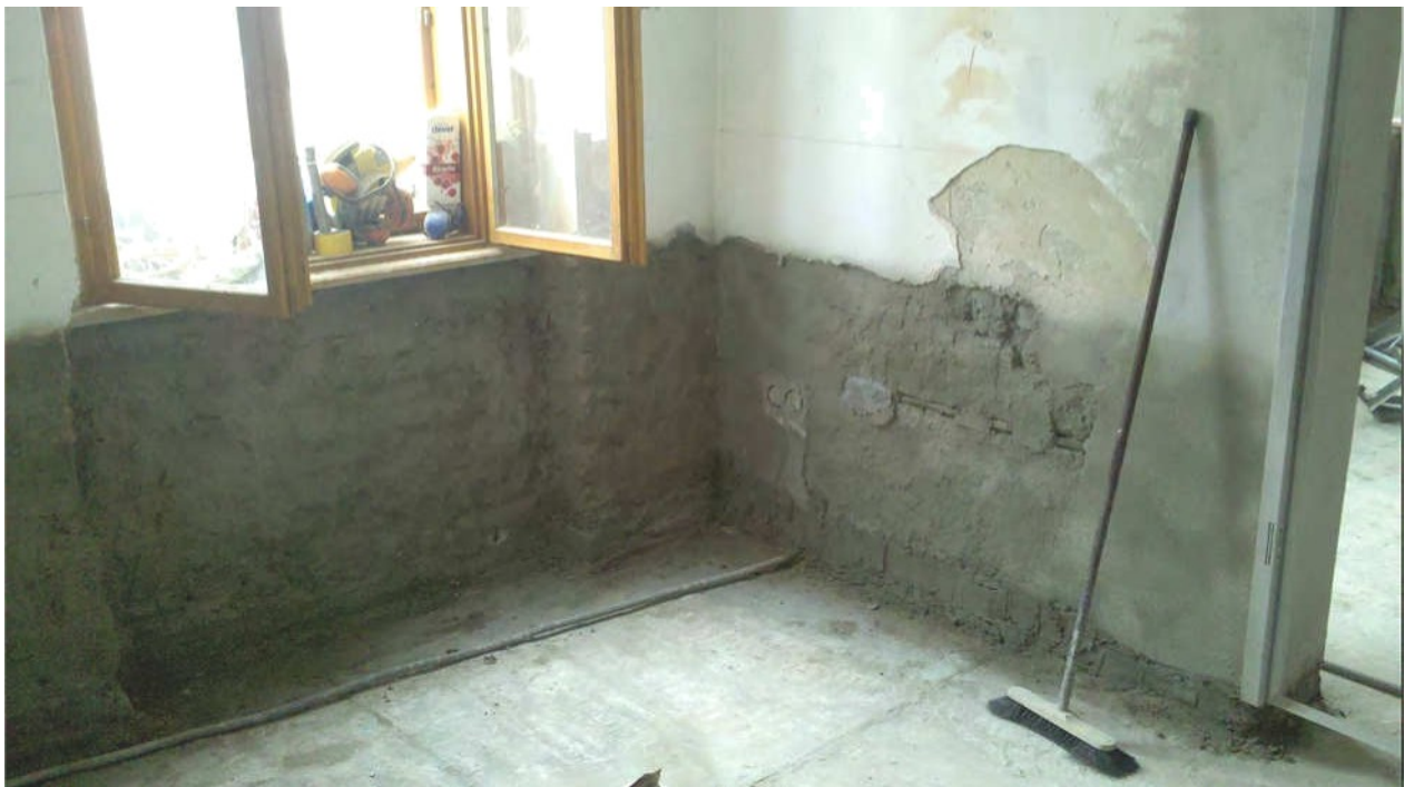
EG-Whg_Strassenseite_waehrend_San_Maueraustrocknung4
