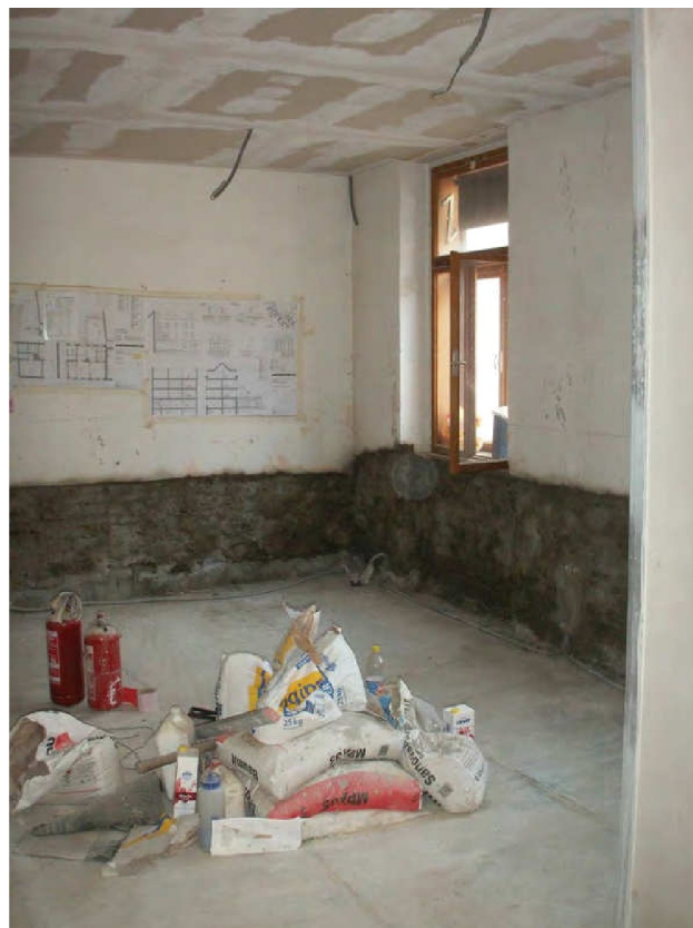
EG-Whg_Strassenseite_Nachbarseite_waehrend_San_Maueraustrocknung_Putz_nellt_auf2
