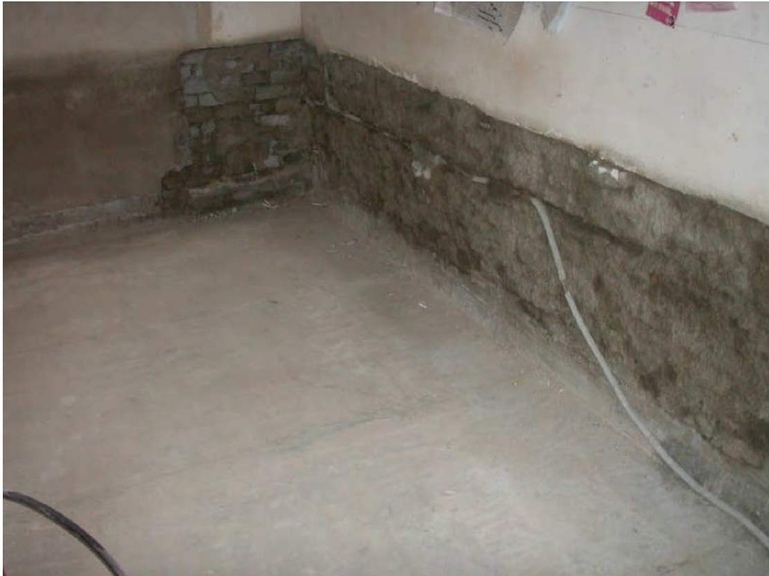
EG-Whg_Nachbarnausseite_waehrend_San_Maueraustrocknung3
