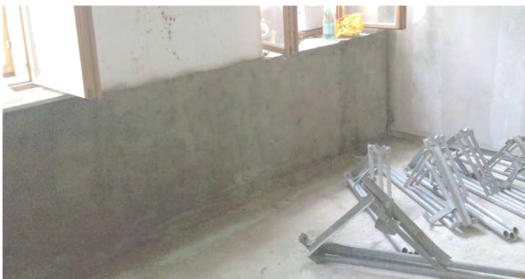
EG-Wng_Strassenseite_waehrend_San_Maueraustrocknung_Putz_hellt_auf2 Begehungen
