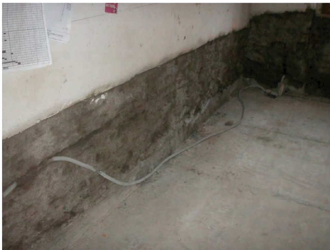
EG-Whg_Nachbarhausseite_waehrend_San_Maueraustrocknung
