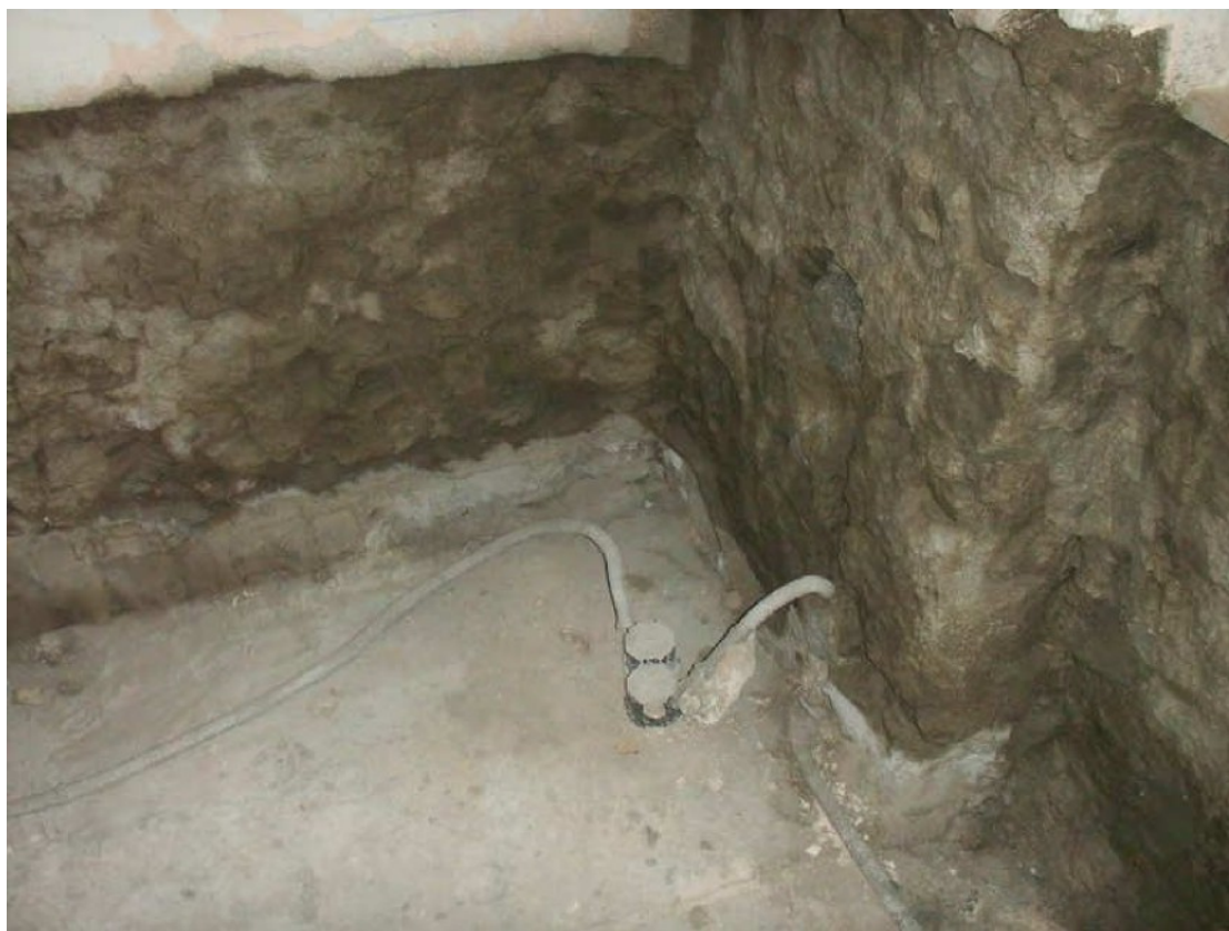
EG-Whg_Strassenseite_waehrena_San_Maueraustrocknung_Putz_hellt_auf
