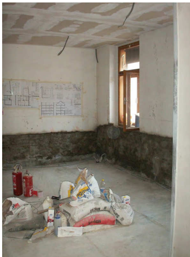
EG-Whg_Strassenseite_Nachbarseite_waehrend_San_Maueraustrocknung_Putz_hellt_auf2
