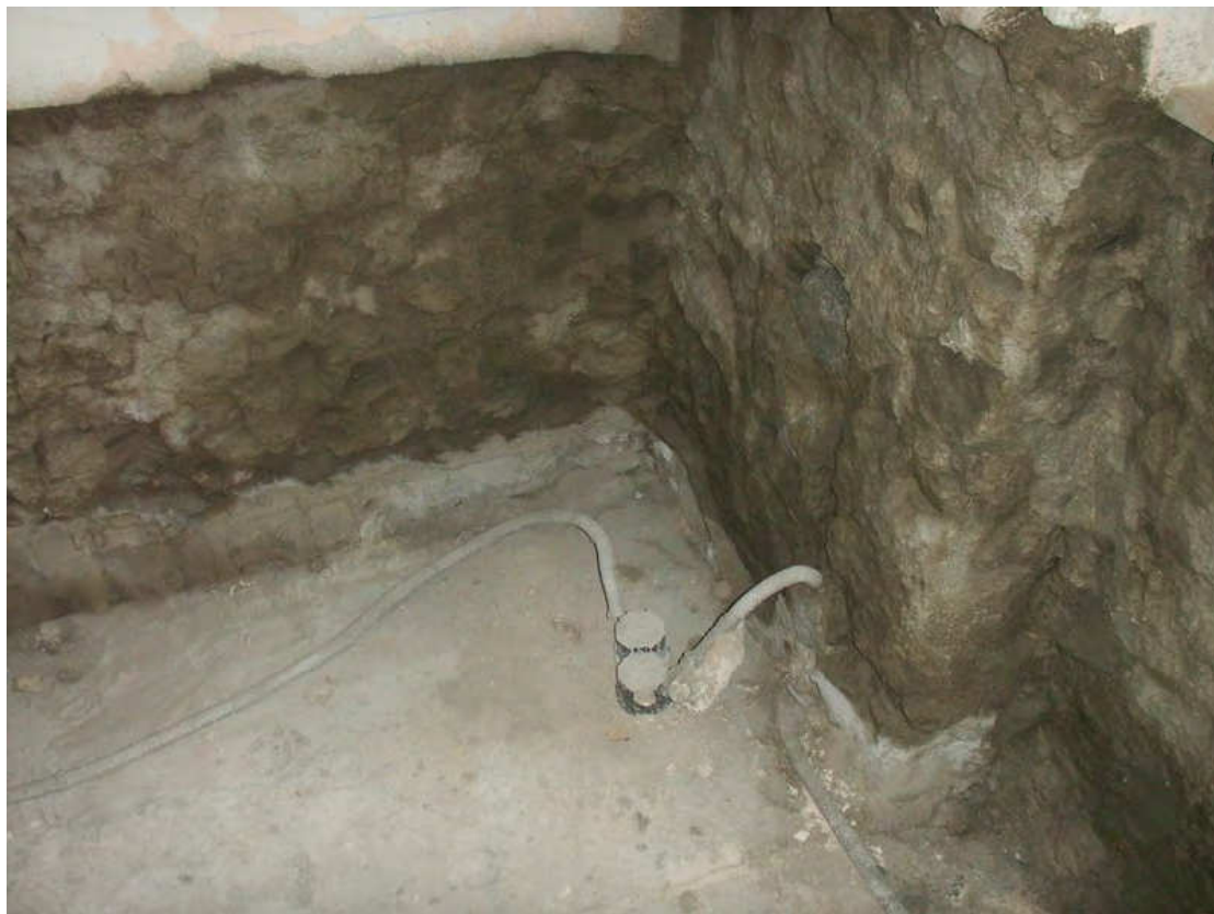
EG-Whg_Strassenseite_waehrend_San_Maueraustrocknung_Putz_hellt_auf
