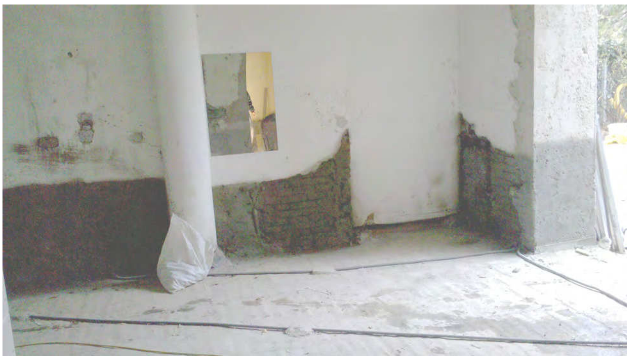
EG-Whg_Einfahrtmuer_waehrend_San_Maueraustrocknung
