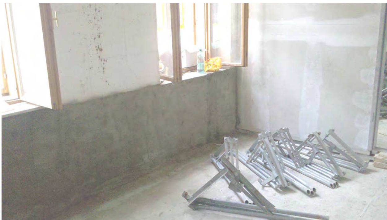
EG-Whg_Strassenseite_waehrend_San_Maueraustrocknung_Putz_hellt_auf2
