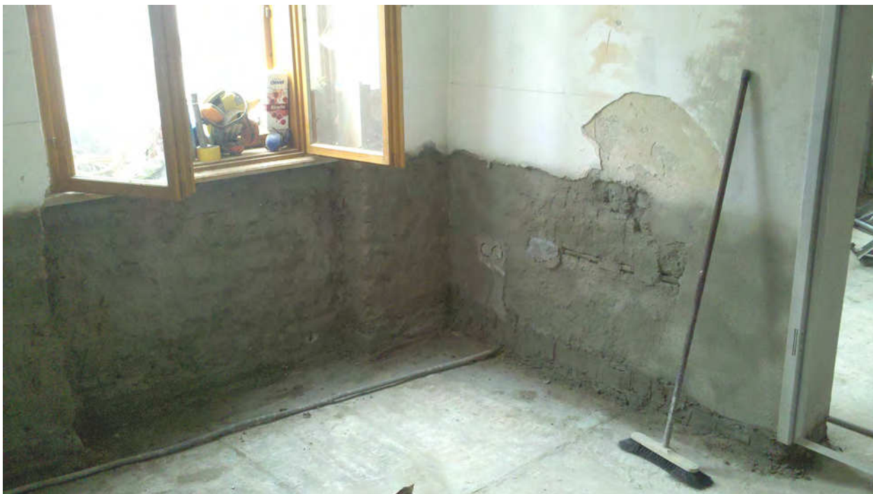
EG-Whg_Strassenseite_waehrend_San_Maueraustrocknung4
